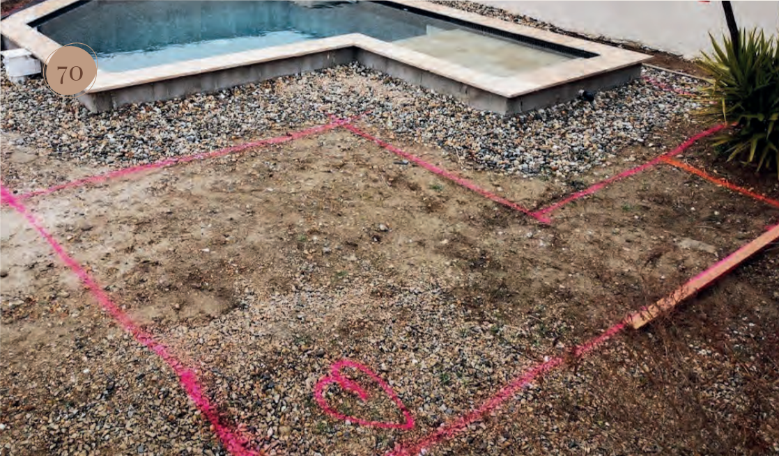
Traçage du chantier...
