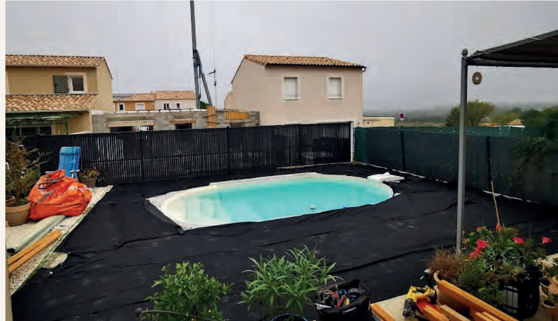
...pose du géotextile...
